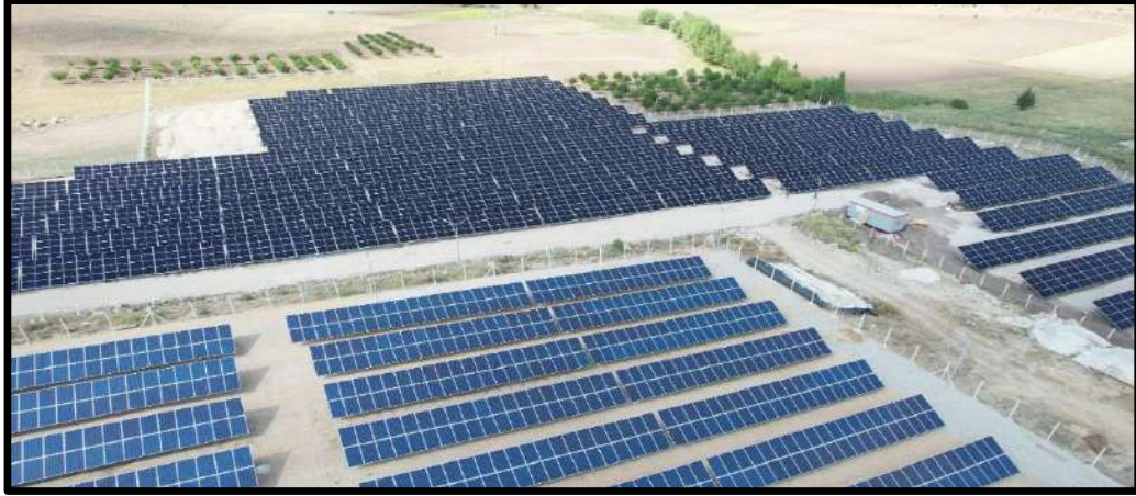
1,3 MW Güneş Enerji Santrali
