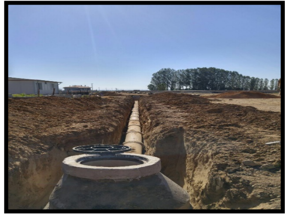
Küçük Çobanlı, İsmail, Bayatçık ve Sadıkbey Mahalleleri Kanalizasyon Şebekesi Hattı Döşeme Çalışmaları
