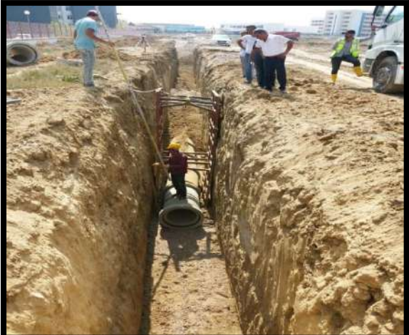
Yenice, Karşıyaka, Battalgazi ve Erenler Mahalleleri Kanalizasyon Şebekesi Hattı Döşeme Çalışmaları
