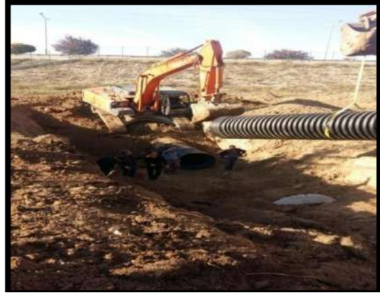
Yenice, Eşrefpaşa ve Kocatepe Mahalleleri Kanalizasyon Şebekesi Hattı Döşeme Çalışmaları
