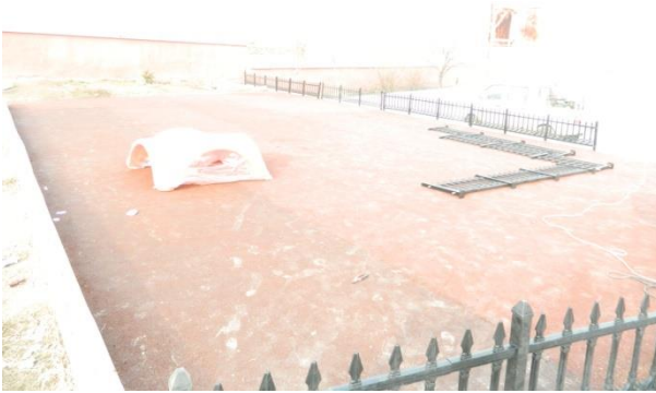
Plastik Ferforje Montajı
