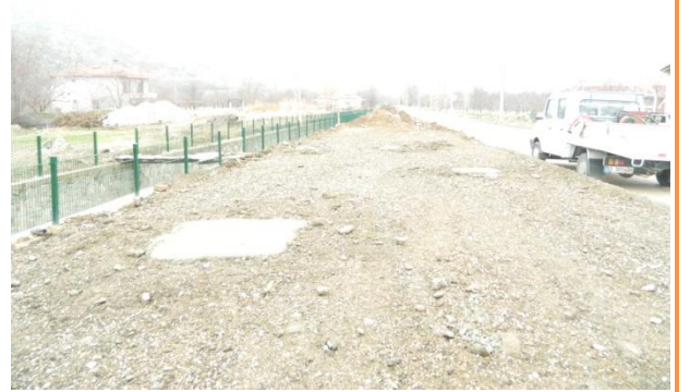
Tel Çit Çekilmesi
