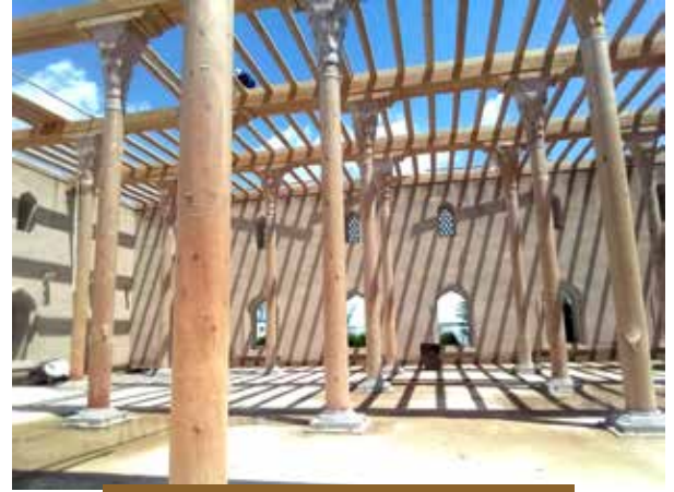
Paşa Camii-yapım aşaması
