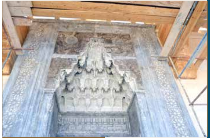
Ana giriş kapısı yapım aşaması
