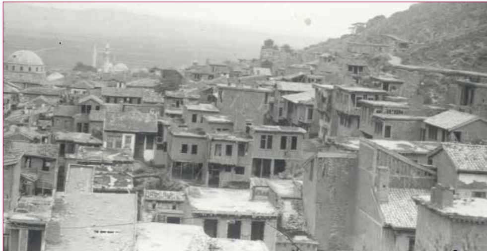
Yangın sonrası evler inşa edilirken
