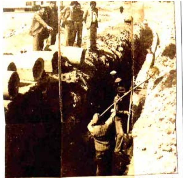
Afyon Belediyesi Fen İşleri ekpleri, Damlupınar Mahallesi kanalizasyon şebekesi yapımını başlattı. 2,5 kilometre uzunluğundaki şebeke için 1,5 milyon lira bütçesiyle çalışılıyor. (Foto: İhsan Fatih GÜMÜŞ - Afyon)
