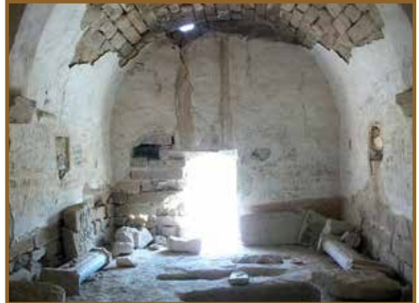
Restorasyon öncesi iç görünüm
