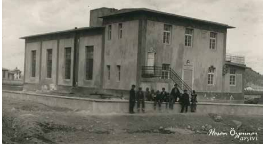
Afyonkarahisar Elektrik Santral Binası
