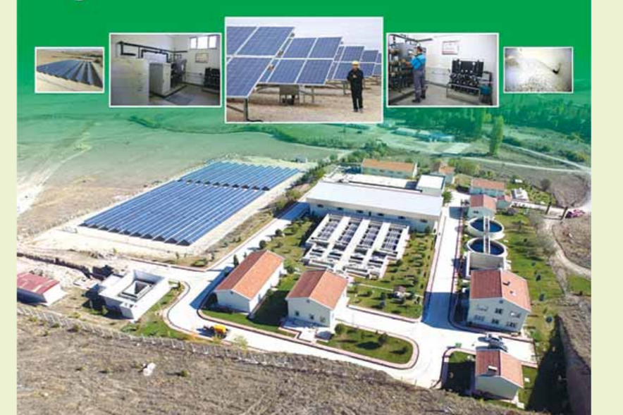
Son yıllarda yaptığı çevreci yatırımlarla adından söz ettiren Afyonkarahisar Belediyesi, şimdi de güneş enerjisinden kendi elektriğini üretiyor.
