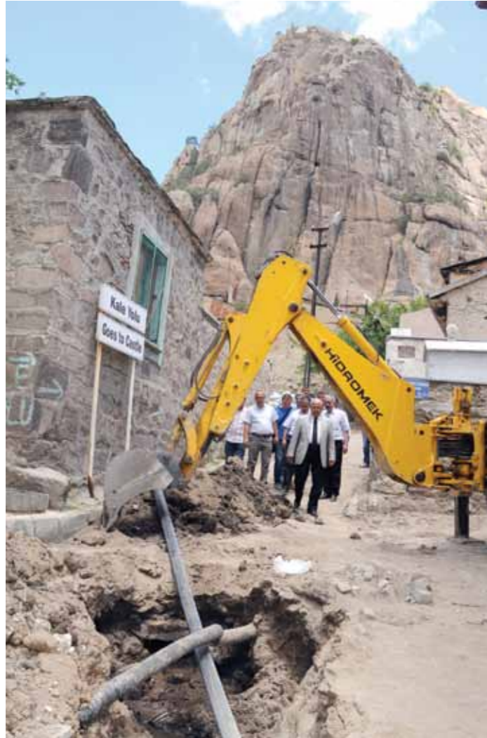
Altyapı çalışmaları sırasında yeraltından çıkan iletire dönmüş boruları gören vatandaşlar, “Biz bu borulardan mı su içiyorduk” demekten kendilerini alamıyor.
