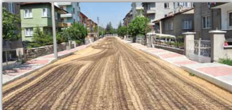
Kaldırımları geçtiğimiz yıl tamamlanan Kocatepe, Nazmi Saatçi ve Gazi mahallelerinin yollarına sıcak asfalt serildi.
