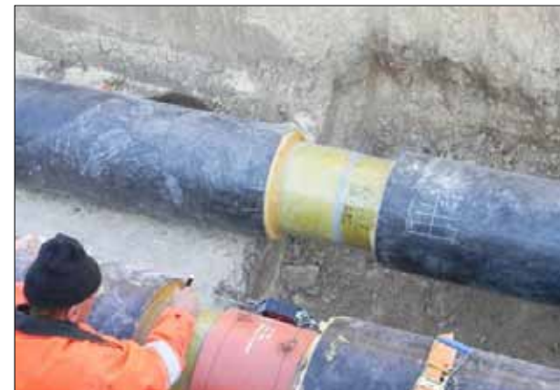
Gre-Epoxy boru montaj çalışmaları
