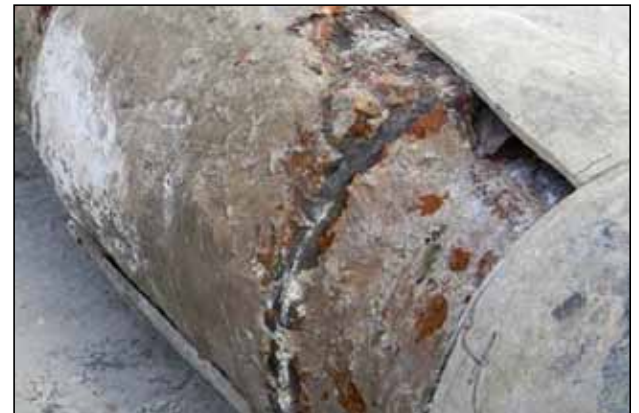
AFJET eski hattı eski boruları
